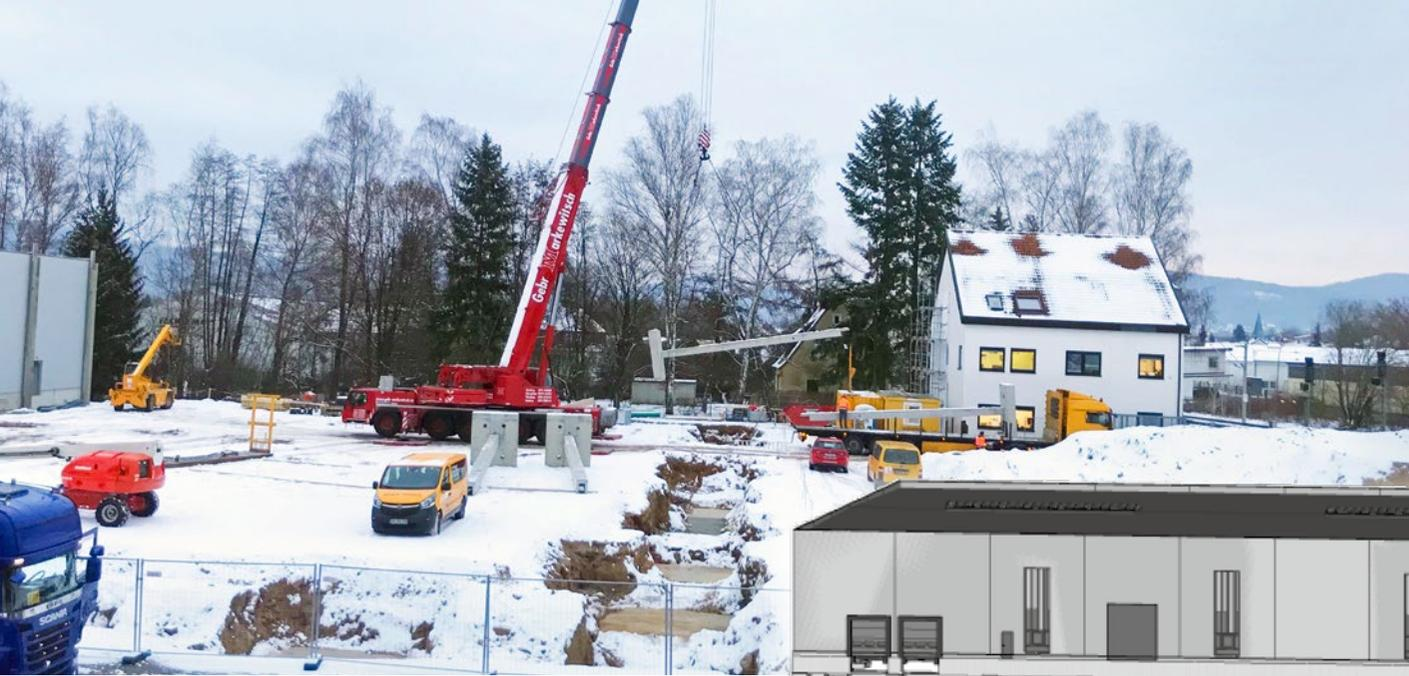
Das neue Logistik-Center von Fackelmann in Hersbruck – ein knapp 3.000 qm großes und fast zehn Meter hohes Bauwerk aus Stahlbeton und Sandwich-Elementen für die Fassade – soll bereits im Frühjahr 2021 fertiggestellt sein. Fotos: Fackelmann
